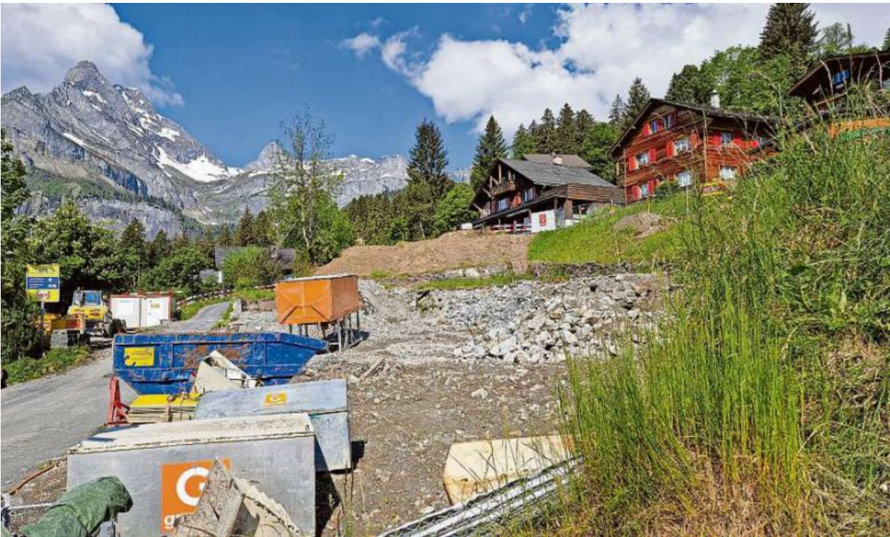
Die Baumaschinen stehen für kurze Zeit still: Die Gemeinde Glarus Süd stoppt die Bauarbeiten für das neue Hotel «Alpenblick».
