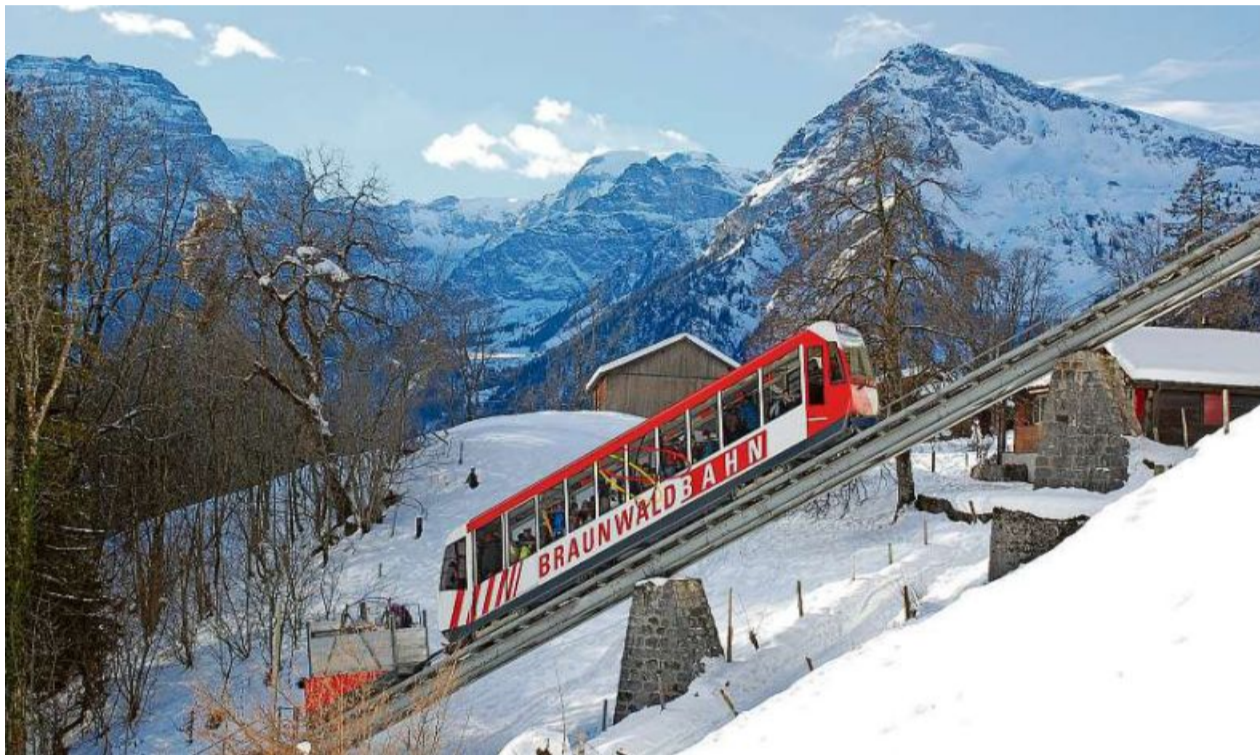
Die Arbeiten beginnen im Juni: Die Braunwaldbahn wird gründlich überholt.
